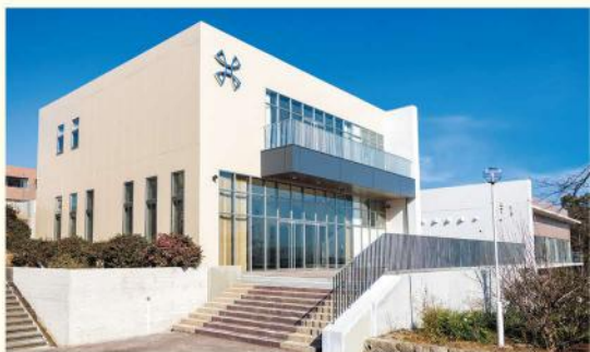
教育棟の外観
